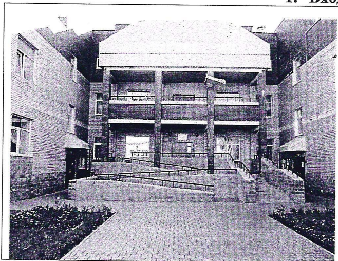
Фото 3 Входная площадка, лестница (наружная), пандус.
