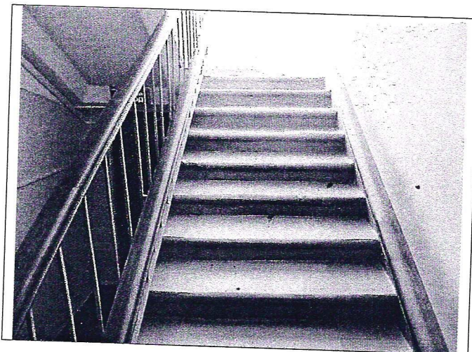
Фото 12 Внутренние лестницы (междуэтажные)
